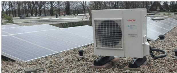
Geen zichtbare installaties op het dak
