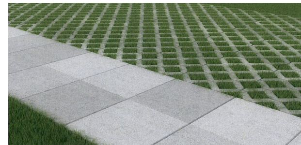
Betontegels met grasbetonstenen gecombineerd
