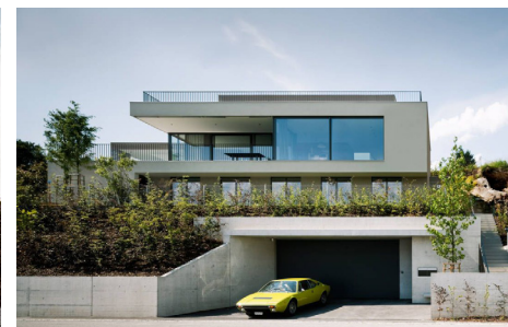
Geconstrueerd damwanden landschap, maaiveld
